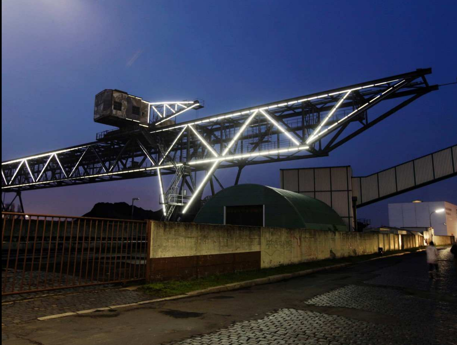
Kohlekran in neuem Licht, 2010 © westermann kommunikation EVO Heizkraftwerk Offenbach, HfG - Hochschule für Gestaltung Offenbach, Meso
